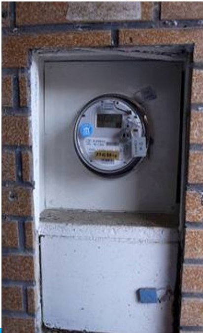
地下室入口被封死 只有這塊可活動
